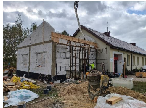
Rozbudowa garażu OSP w Nowym Żabieńcu.
